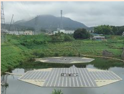
池に浮かぶ太陽光パネル
